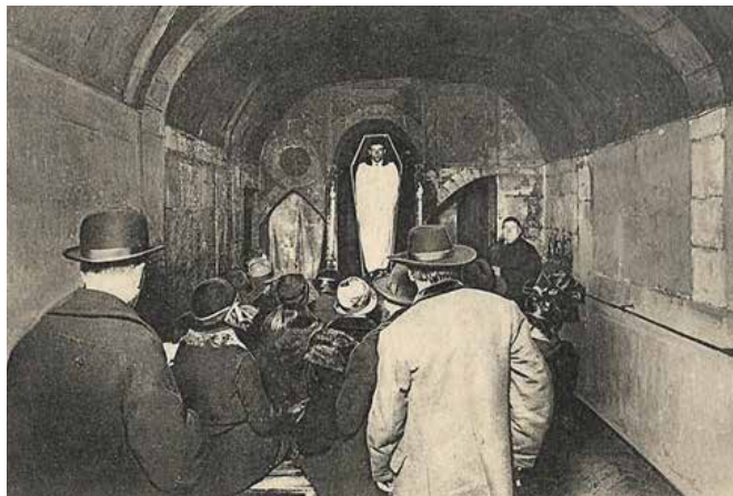
Caveau des Trépassés (Phase 1). Coll. Hjalmar
